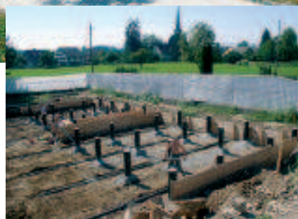
...während der Bauphase.
